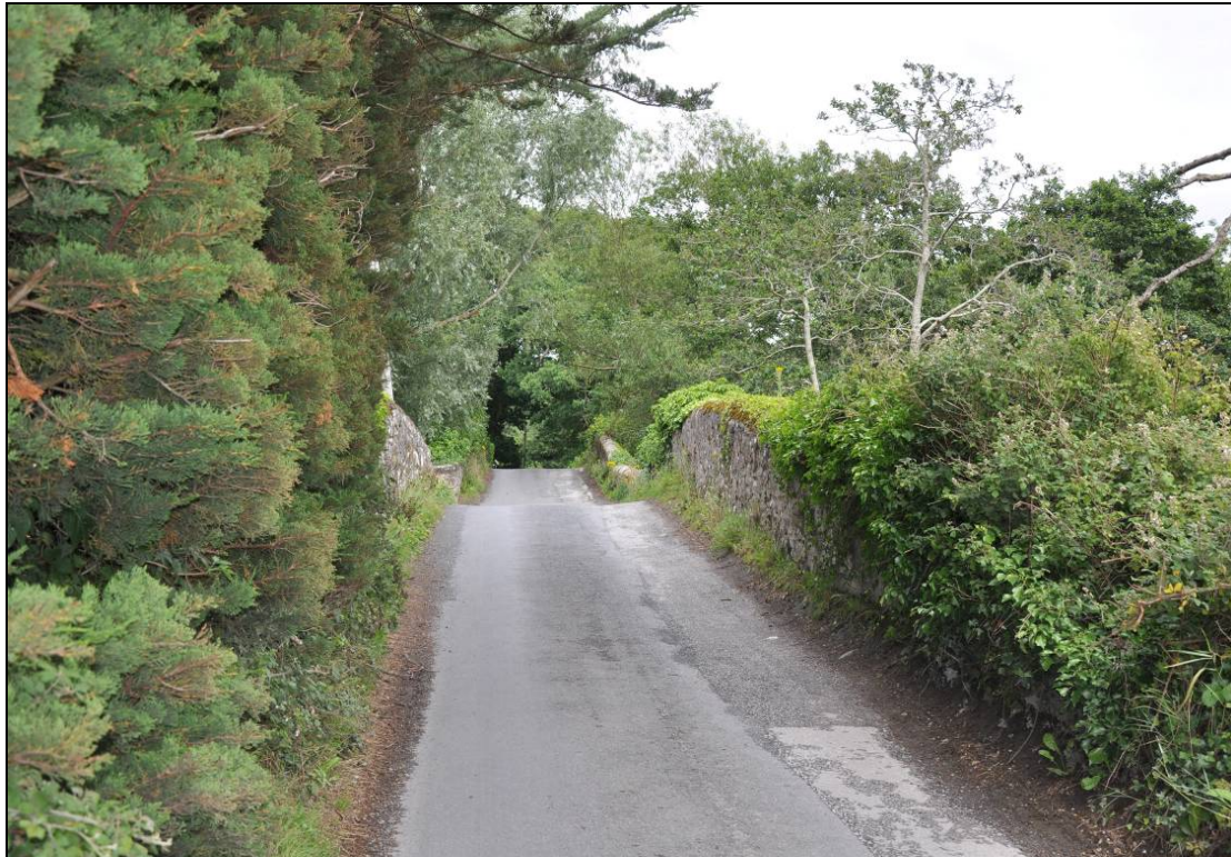
Photo 3.4.6 –Existing Gilloge Bridge
